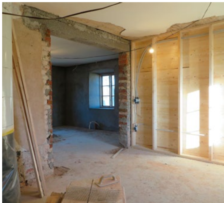
Fotografi från rum 2106 mot rum 2104 efter upptagning av en ny öppning. Till höger syns den nya väggen mot skafferiet (rum 2105).
