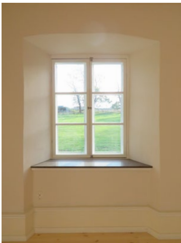
Fönster mot söder efter avslutade arbeten.
