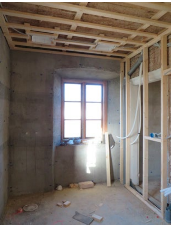
De båda sammanslagna rummen under pågående renovering. Fotografi mot norr.
