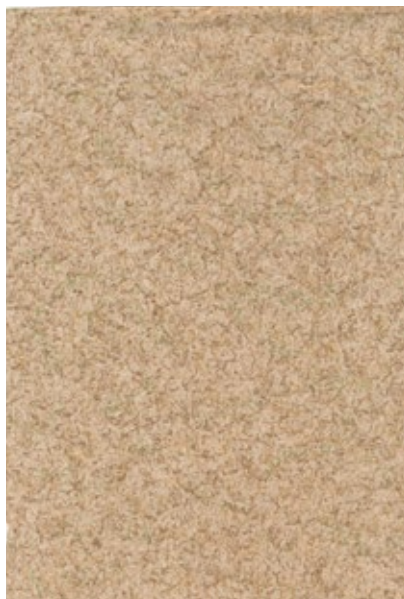
Befintlig tapet i rum 2104.
