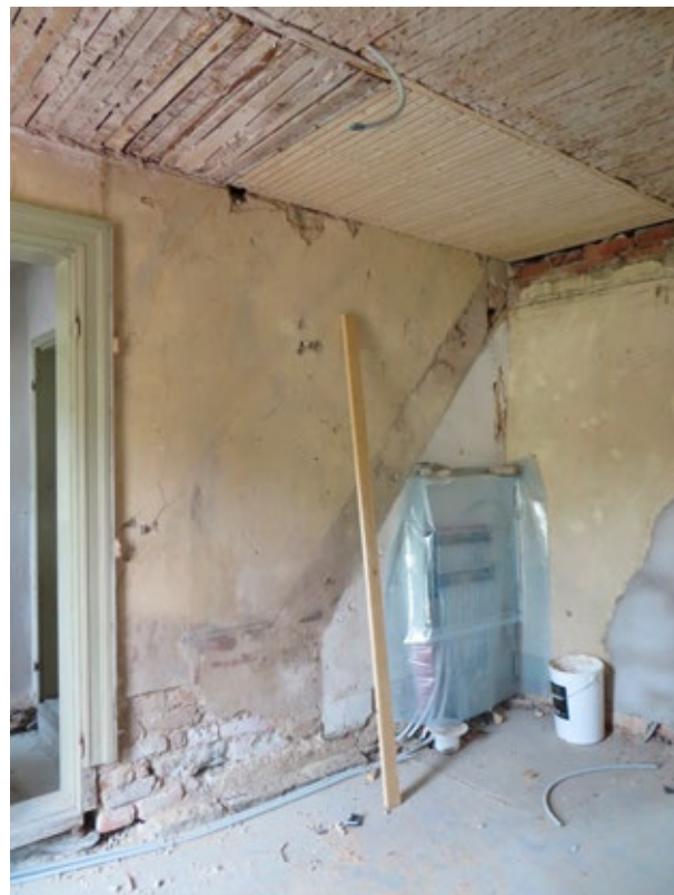
Fotografi taget efter demontering av trappa och igensättning av bjälklagsöppning.
