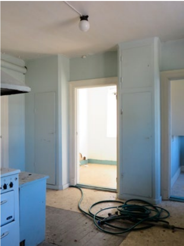
Rum 2110 före renovering.
