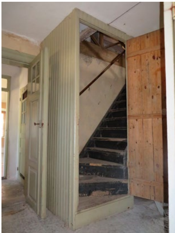
Trappan var från 1870, medan dörren och de övriga delar av inklädnaden som utförts av pärlspontpanel troligen tillkommit någon gång mellan sekelskiftet 1900 och 1920-talet.
