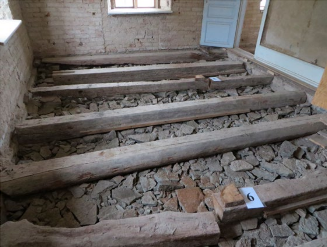
Frilagda golvbalkar i rum 2104. Fotografi taget i samband med provtagning för dendrokronologisk datering. De båda avsågade balkarna daterades till perioden 1784-1787.
