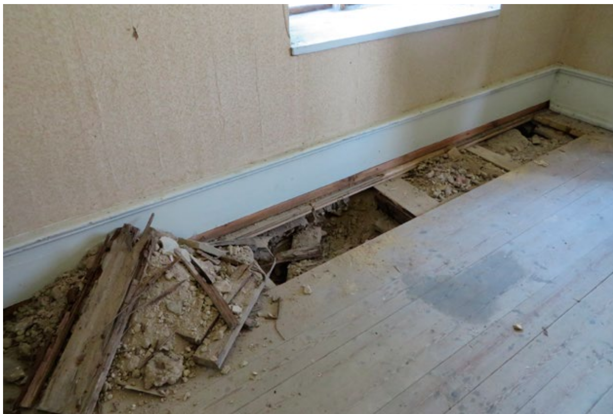
Fotografi från undersökning av golvbjälklag i rum 2104.
