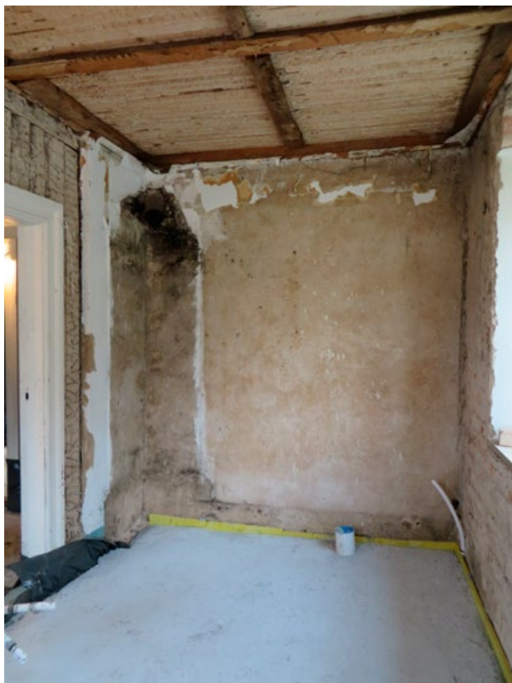
Rum 2111 efter demontering av kakelugn.
