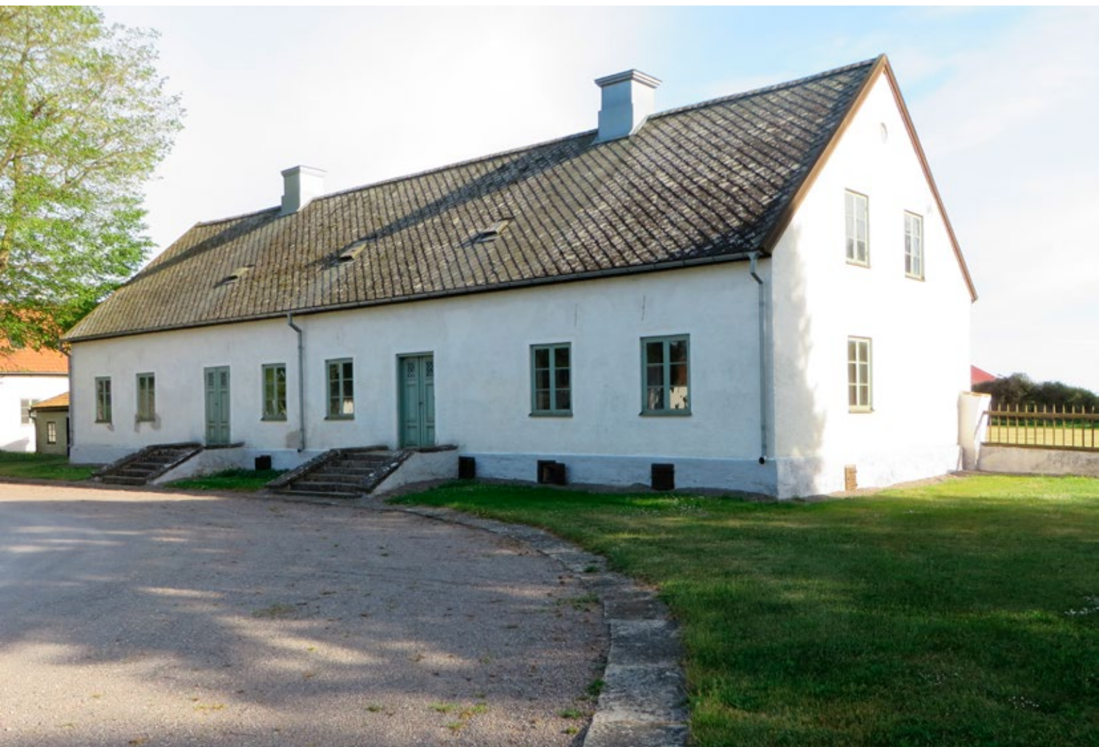
Flygeln sedd från gårdens huvudbyggnad i nordväst. I takfallet syns tre gamla gjutjärnsfönster. Takfönstren är troligen bevarade från 1870. Skifferbeläggningen lades om 2001.
