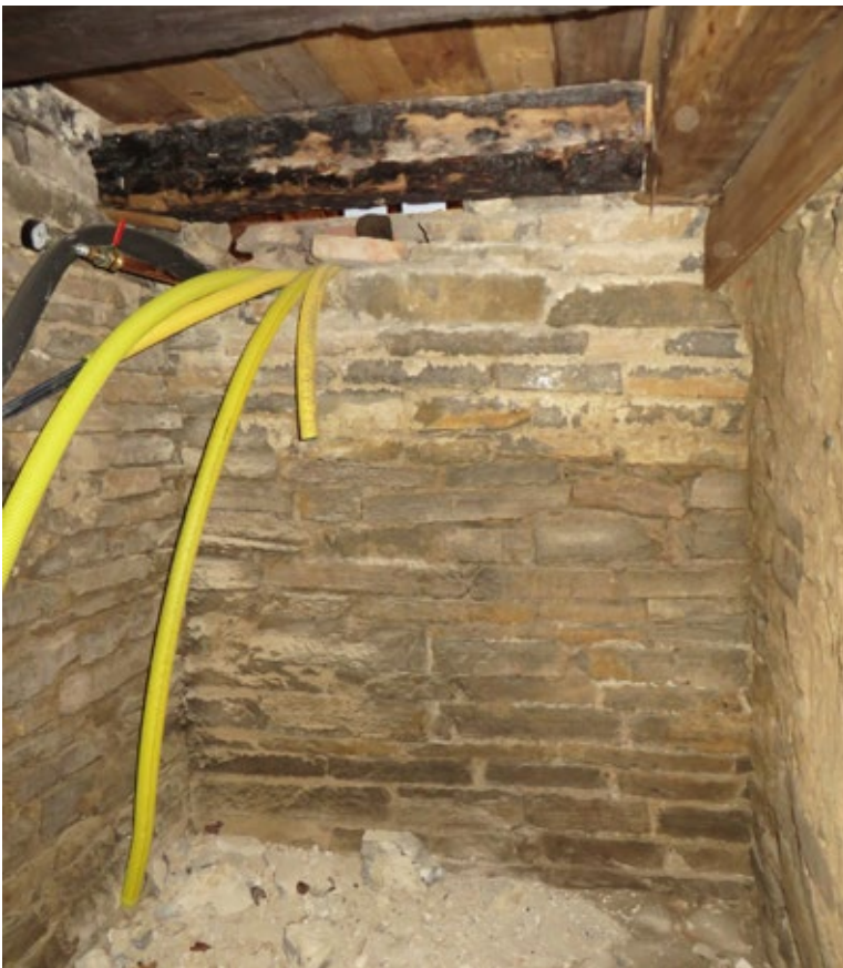
Öppning i södra fasadens sockel för anslutning av jordvärmeanläggningens slangar.
