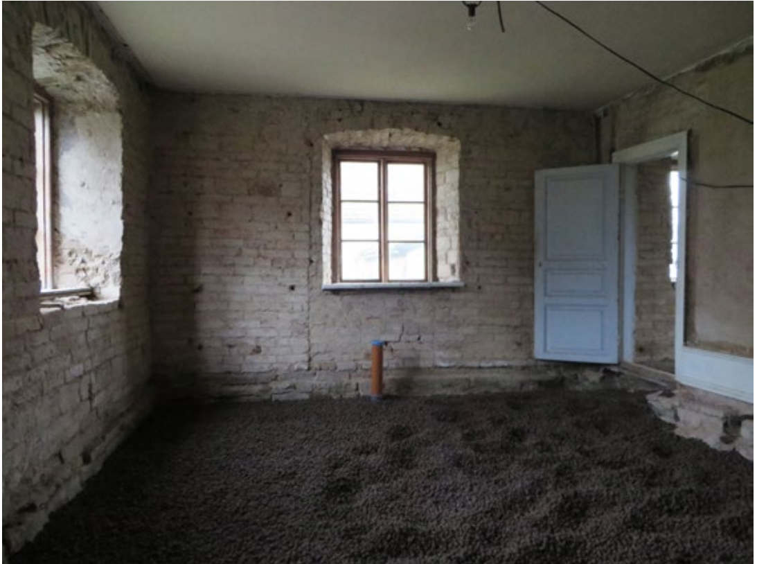
Rum 2104. Alla delar av det gamla träbjälklaget har tagits bort och markytan har täckts med leca.
