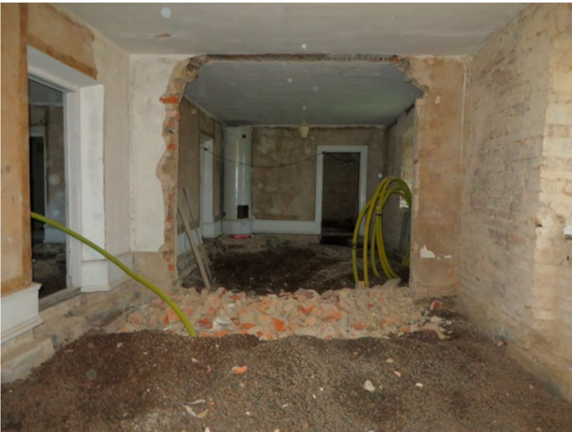
Rum 2108 mot rum 2107 efter nyligen genomförd rivning för öppning i innervägg.
