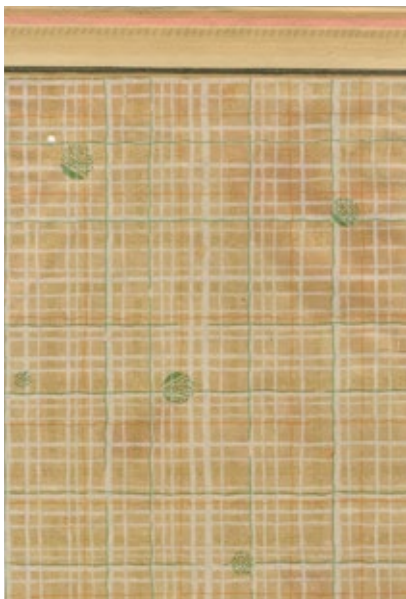
Befintlig tapet i rum 2101.
