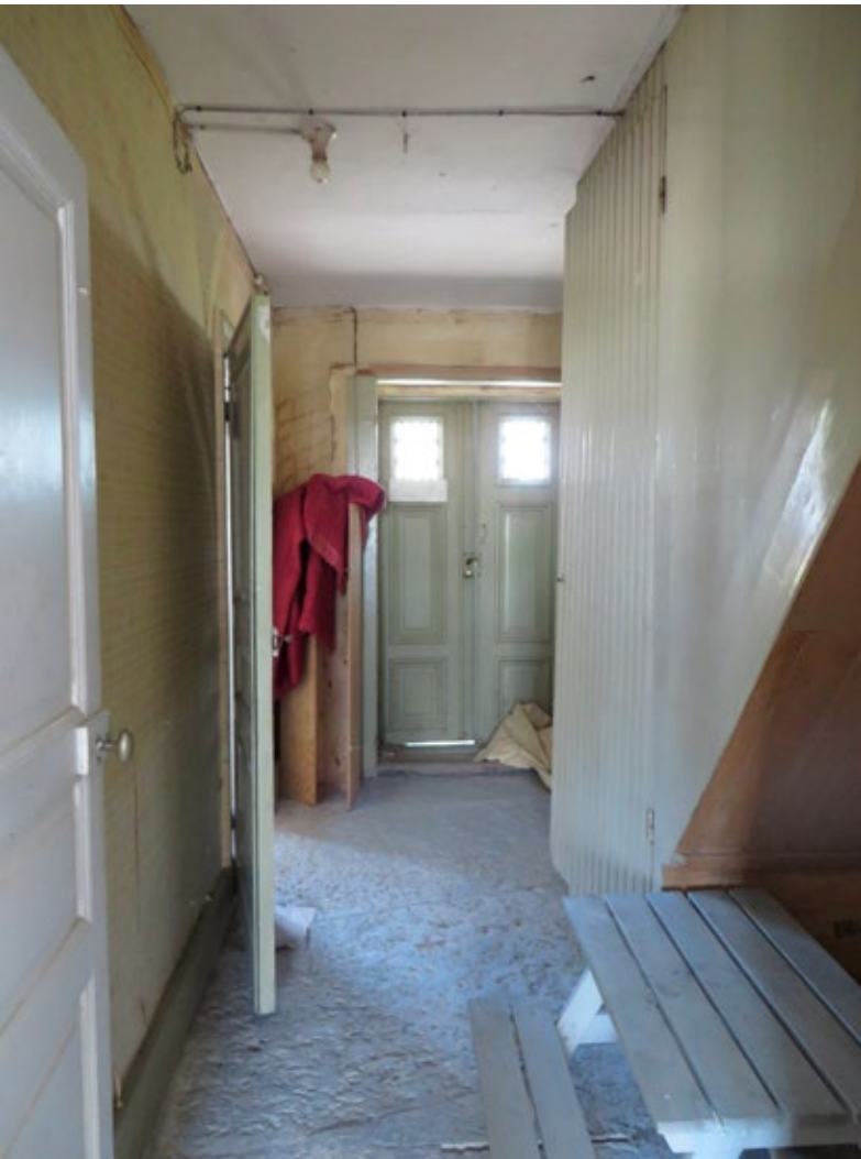
Östra entréns farstu (rum 2101) före renovering.
