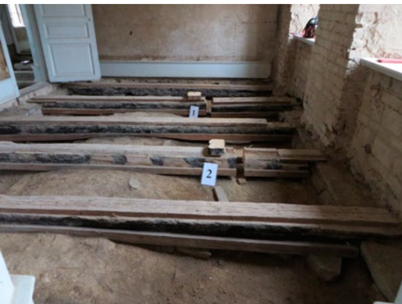
Fotografi från dendrokronologisk provtagning av balkar i rum 2115. Tillsammans med tre andra prover daterades prov 1 och 2 till perioden 1784-1787.
