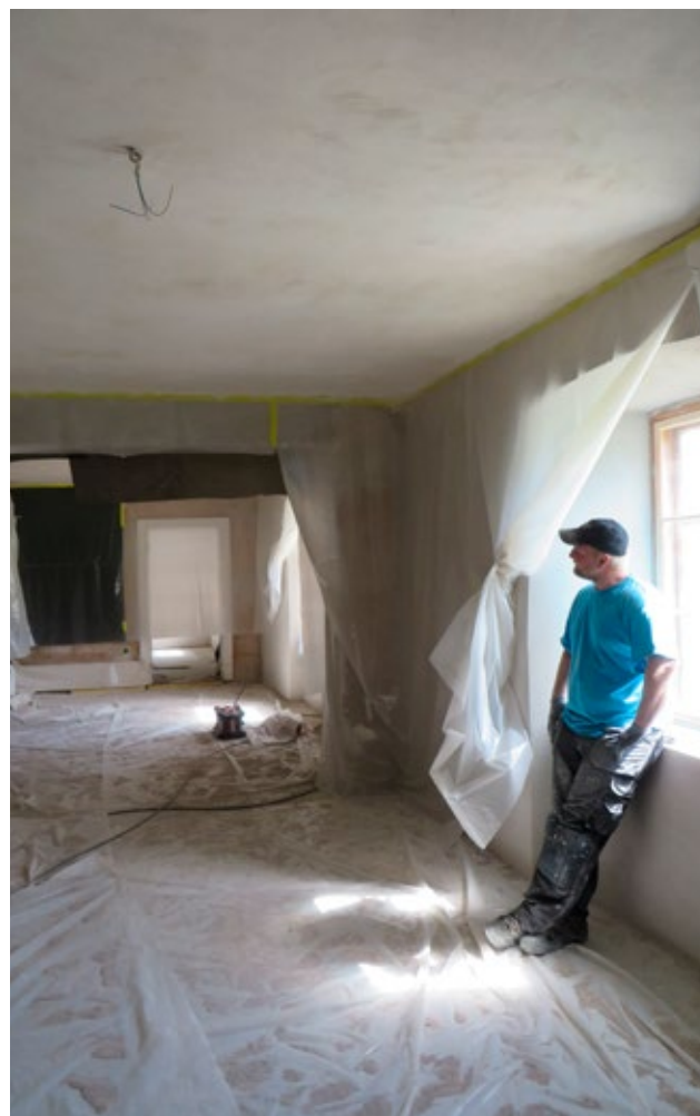
De putsade innertaken ströks med flera extra skikt kalkfärg, tills variationerna i struktur och kulör försvunnit. På bilden syns Michael Kornelius från Calmarsunds Mur & Fasad AB.
