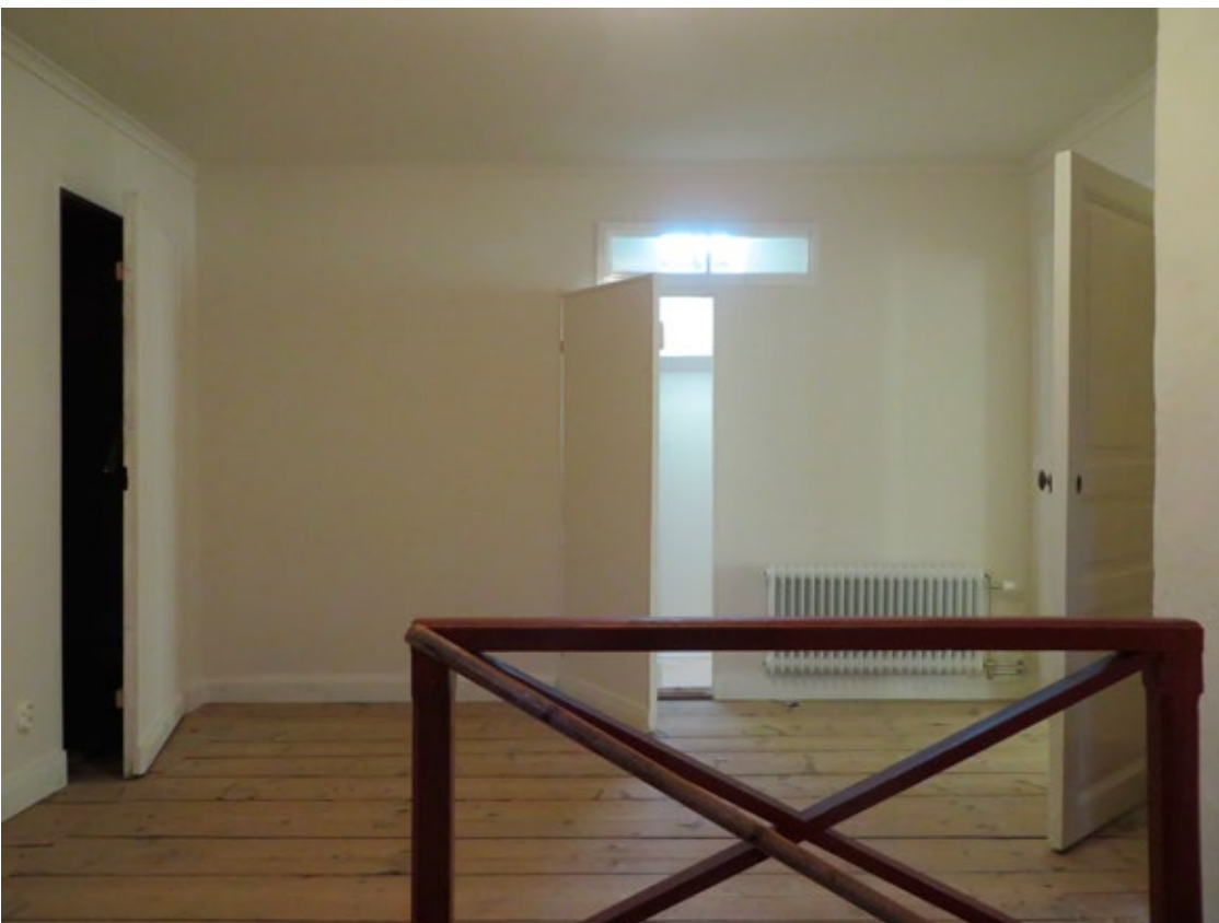
Övervåningens hall (rum 2204) efter åtgärd. Fotografi mot söder. Plankväggen rakt fram i bild har bevarats, men höjden på fönstret över dörren har minskats.
