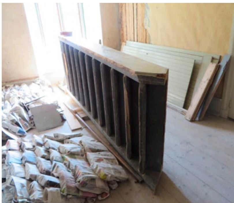
Trappan förvaras i det nordöstra gavelrummet (rum 2202) på andra våningen. I rummet finns även kakel från de båda kakelugnar som demonterats.
