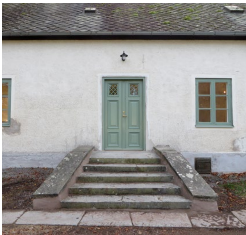
Östra entrén efter omläggning av trappa och byte av entrédörr.
