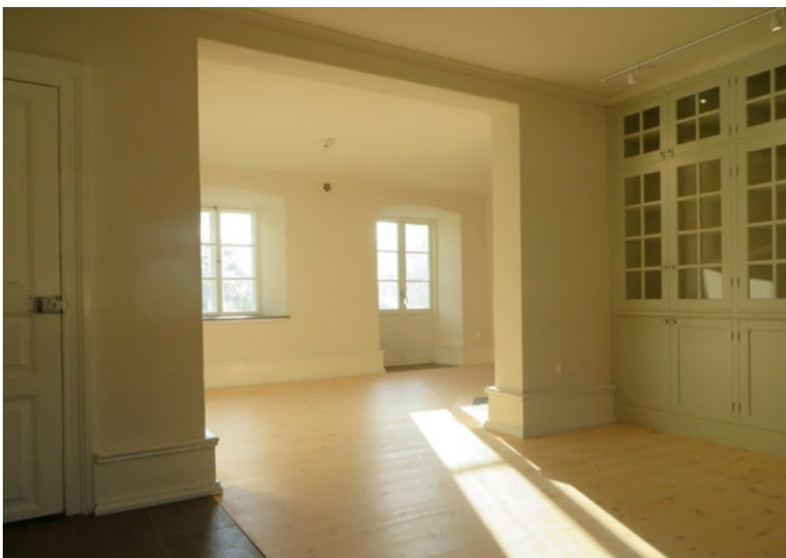
Fotografi från rum 2104 mot rum 2106 efter upptagning av en ny öppning.
