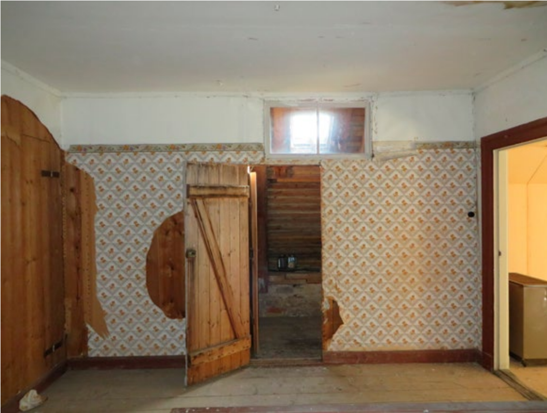
Övervåningens hall (rum 2204) före åtgärd. Fotografi mot söder.
