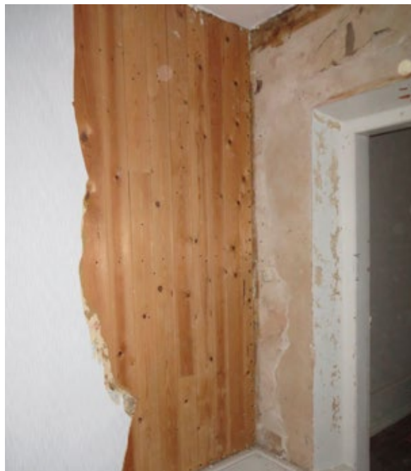
Frilagd panelbeklädnad i rum 2106.
