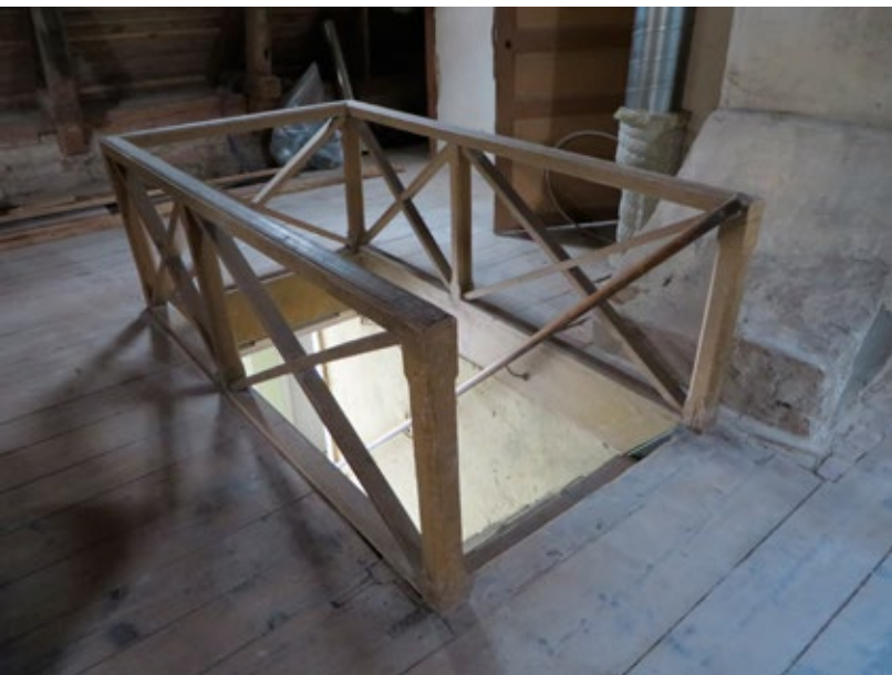
Räcke från 1870 omkring bjälklagsöppningen på andra våningen (rum 2201).
