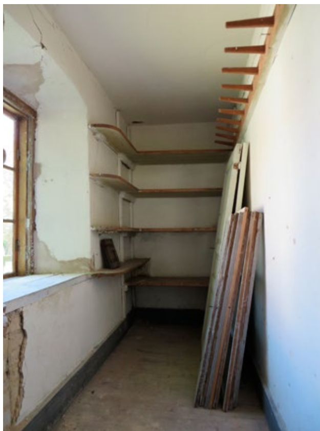
Skafferiet (rum 2105) före åtgärd.
