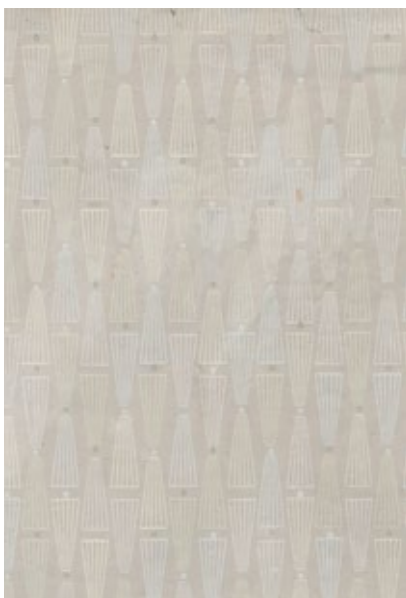
Befintlig tapet i rum 2107.
