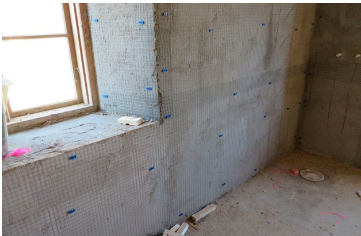
Ytterväggarnas invändiga beklädnad av träpanel från omkring 1920 ersattes av cementbundna träullsplattor. Närbild från pågående arbeten i rum 2112.
