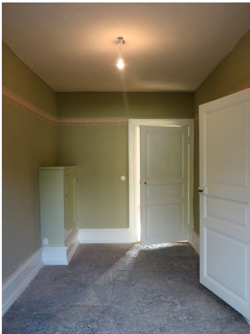
Östra farstun (rum 2101) efter avslutade arbeten.
