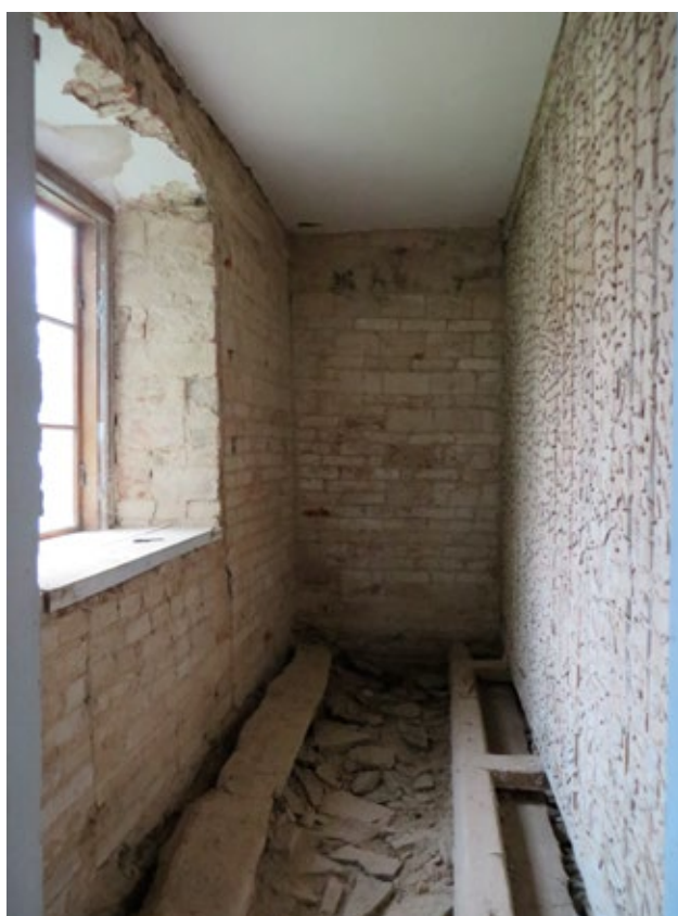
Skafferiet efter rivning av bjälklaget och väggarnas putsskikt. Innerväggen till höger, mot rum 2106, var byggd av grova stående plankor.
