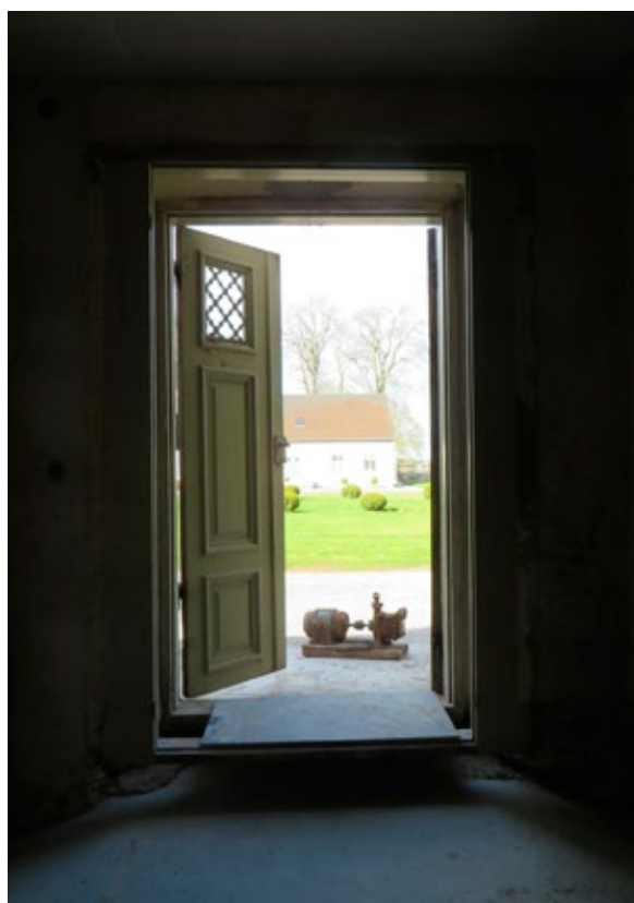
Östra entréns pardörr sedd från insidan före åtgärd.
