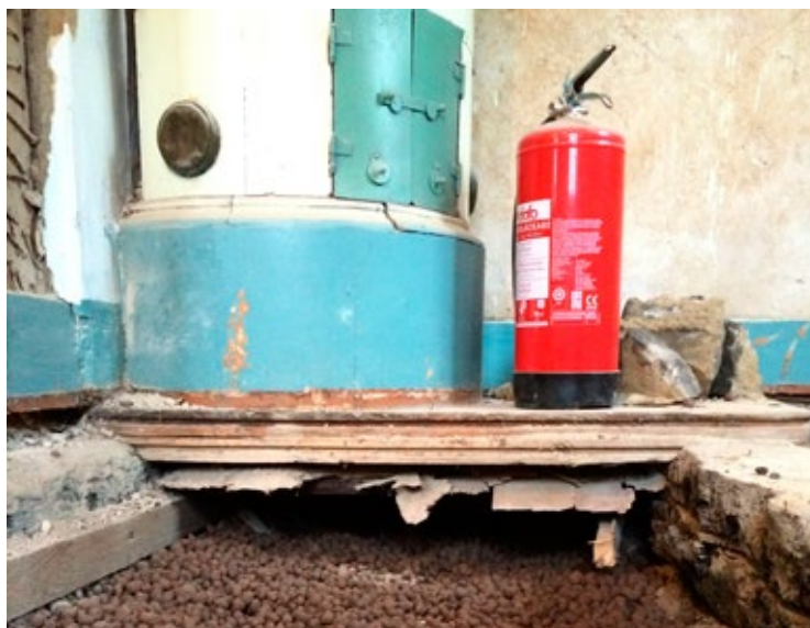
Kakelugnen i rum 2111, det blivande badrummet, stod ovanpå brädgolvet. Bottenvåningens övriga kakelugnar hade en grundläggning av kalksten.
