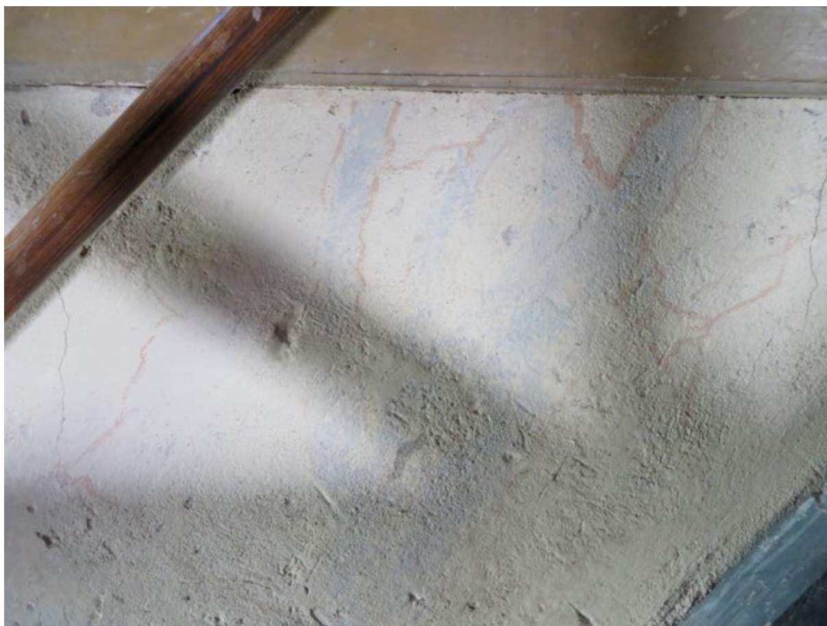
På den östra entréns (rum 2101) putsade väggar syntes rester av marmoreringsmålning utförd med kalkfärg.
