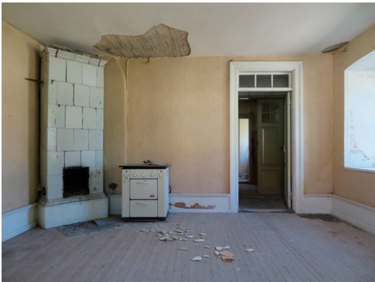
I det rum som efter ombyggnad används som kök (rum 2104) fanns en rektangulär empirkakelung tillverkad omkring 1820. Kakelugnen demonterades för att ge plats åt ny skåpsinredning, se fotografi på sidan ??.
