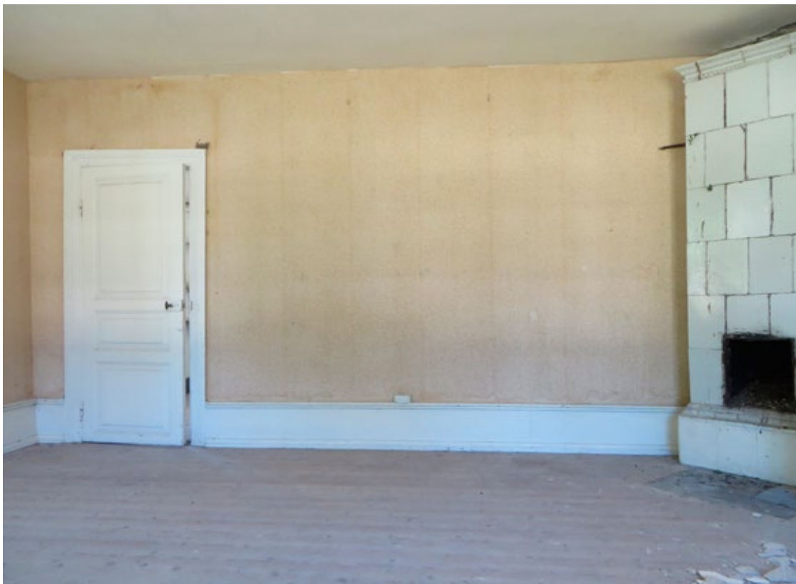
Vägg mot söder i rum 2104 före åtgärd.
