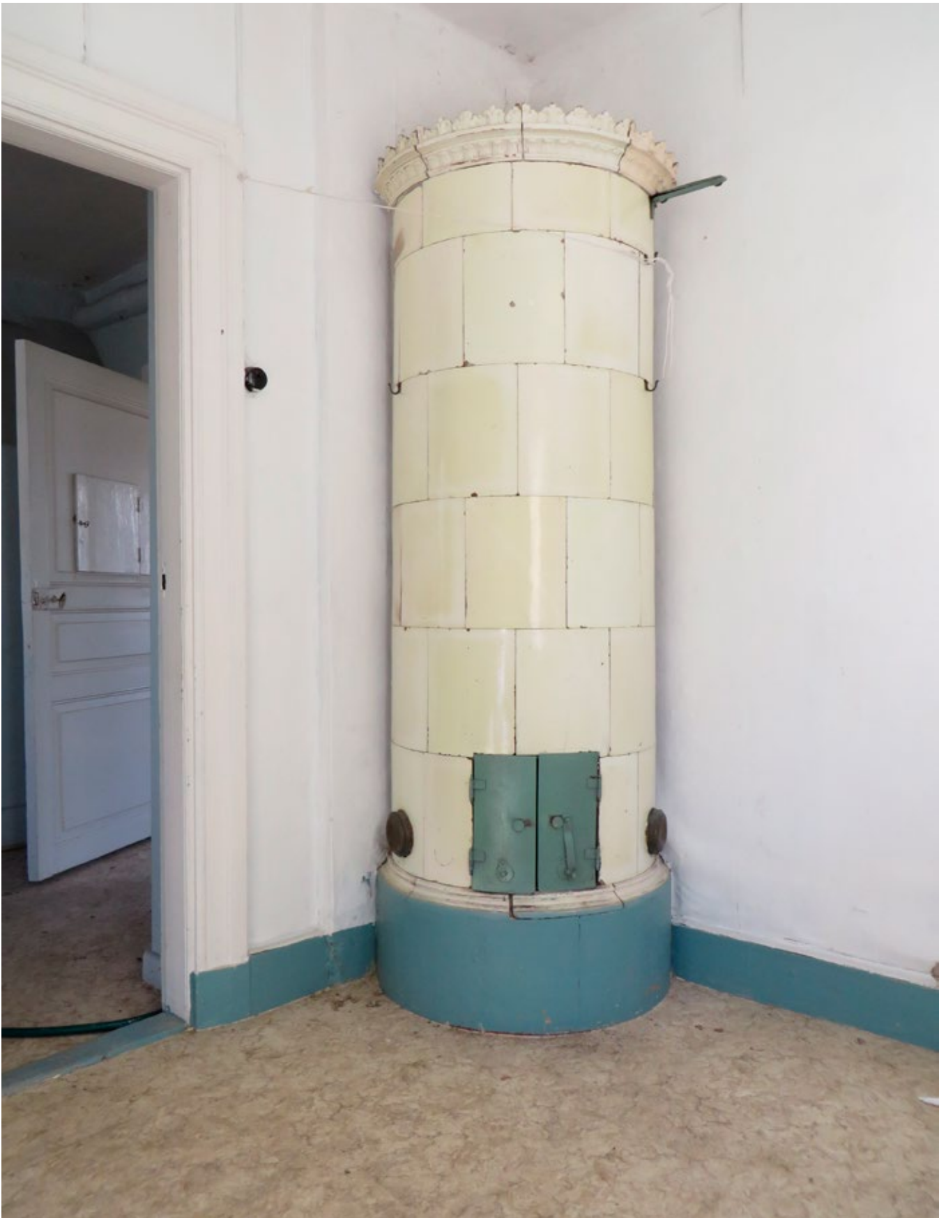
Kakelugn i rum 2111 före demontering.
