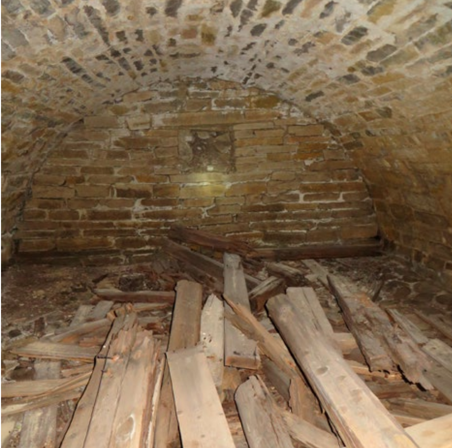
Källarens rum längst åt öster före åtgärd.
