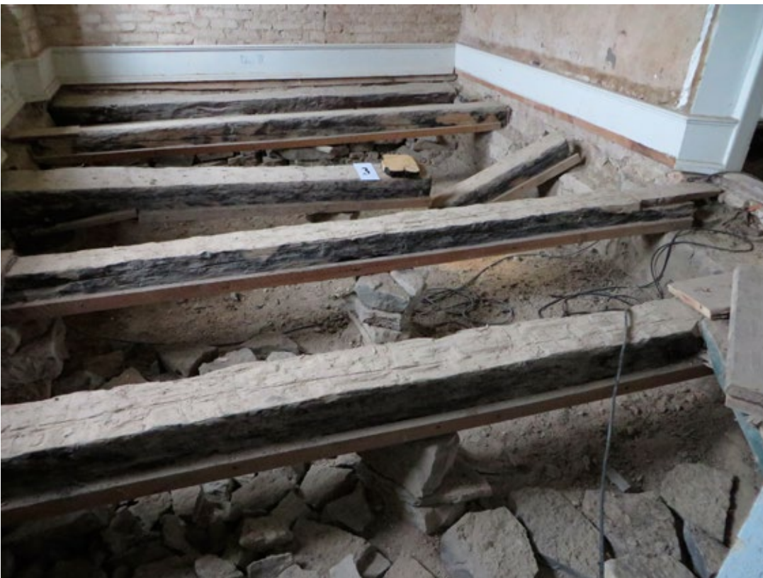
Frilagda golvbalkar i rum 2109. Fotografi taget i samband med provtagning för dendrokronologisk datering. Den avsågade balken daterades till perioden 1798-1802.
