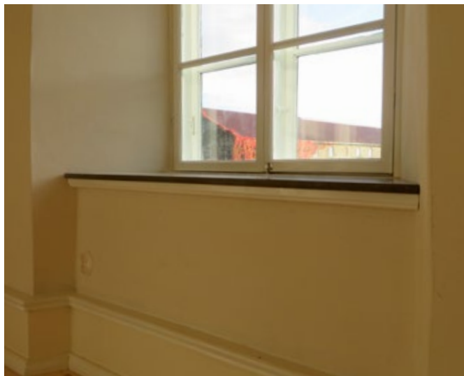
För att tillgodose brukarnas önskemål om att kunna lägga kalkstensskivor i fönsternischerna är de nya fönsterbänkarna av trä är något tunnare än de gamla var.
