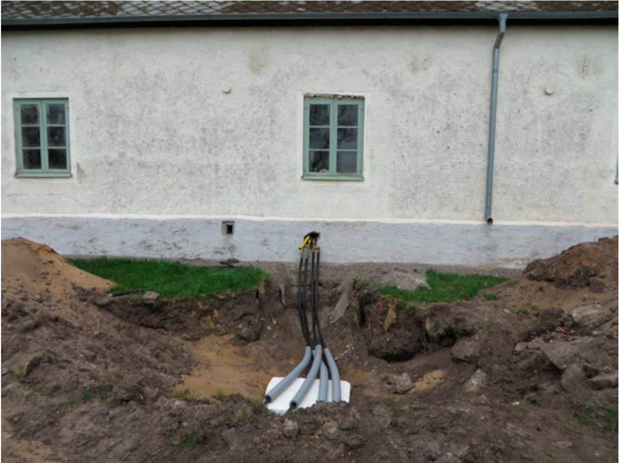
Öppning i södra fasadens sockel för anslutning av jordvärmeanläggningens slangar.
