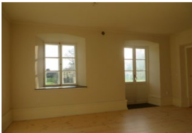
Rum 2106 efter komplettering med ny altandörr.
