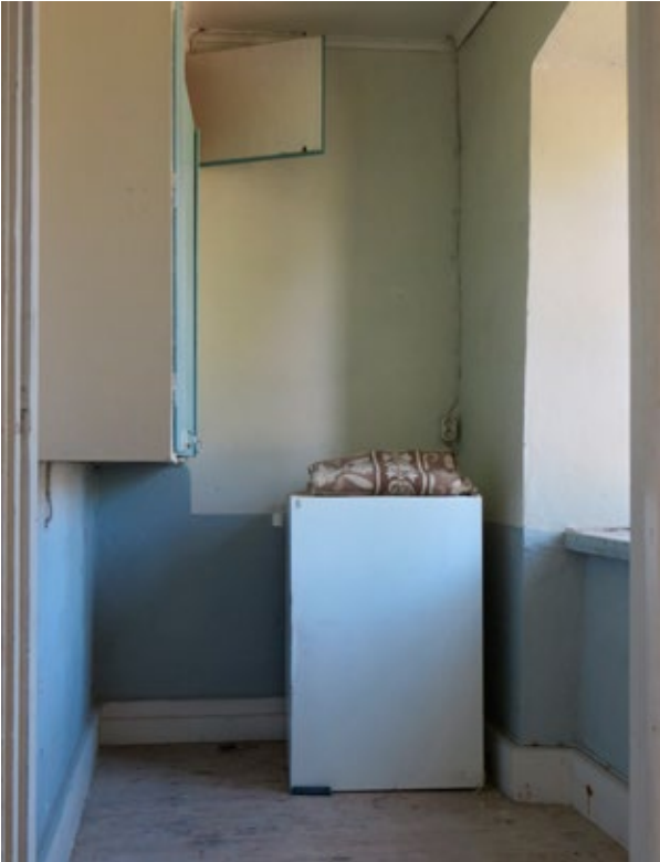
Rum 2112 före åtgärd. Enligt ansökningshandlingarna skulle rummet efter renovering användas som dusch, med egen dörr mot grovköket (rum 2110).
