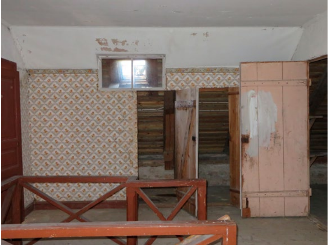
Övervåningens hall (rum 2204) före åtgärd. Fotografi mot norr.
