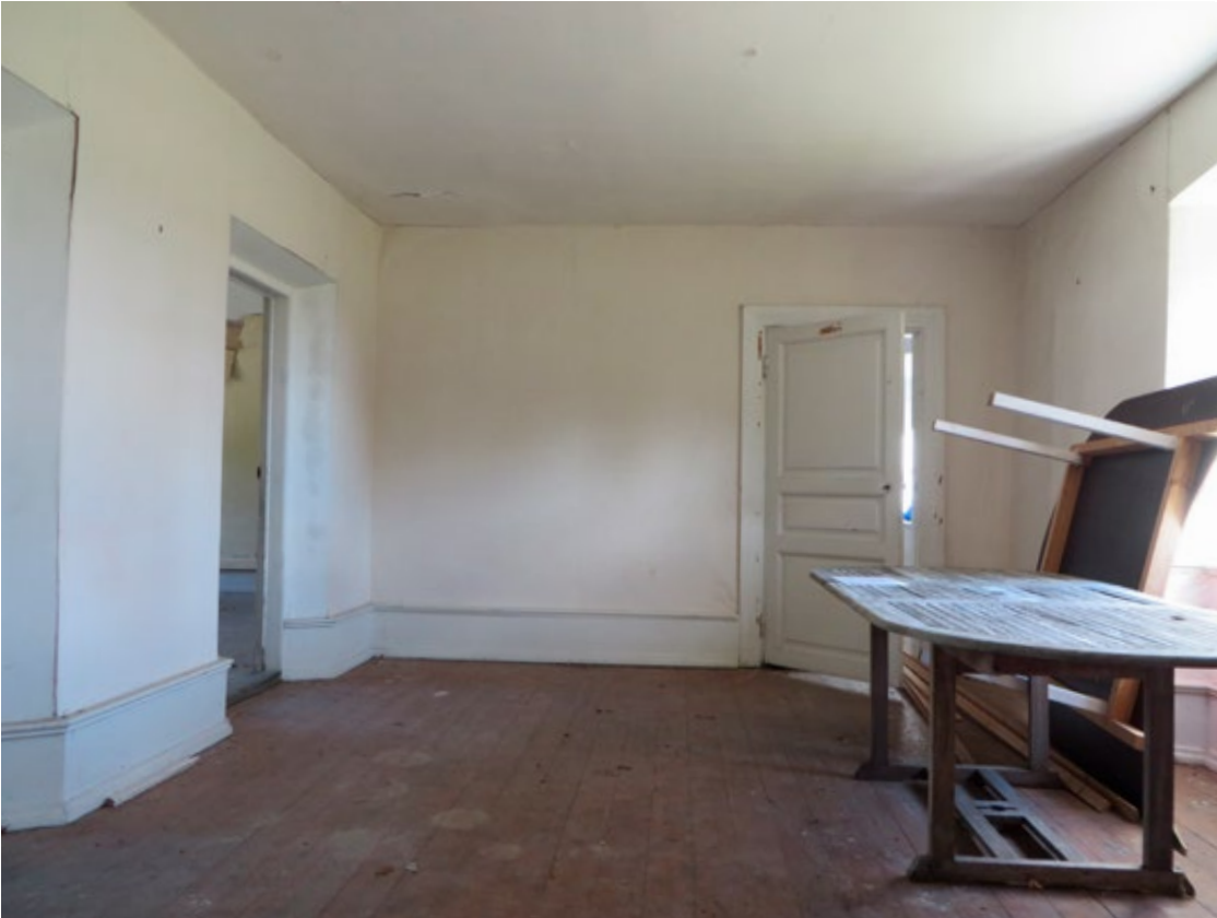
Rum 2108 mot öster före åtgärd.
