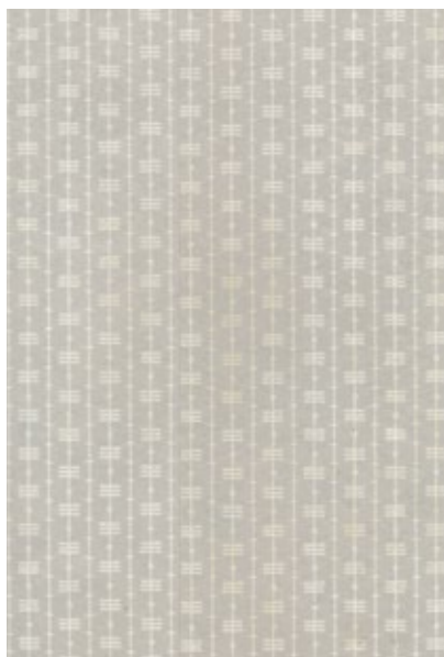
Befintlig tapet i rum 2109.
