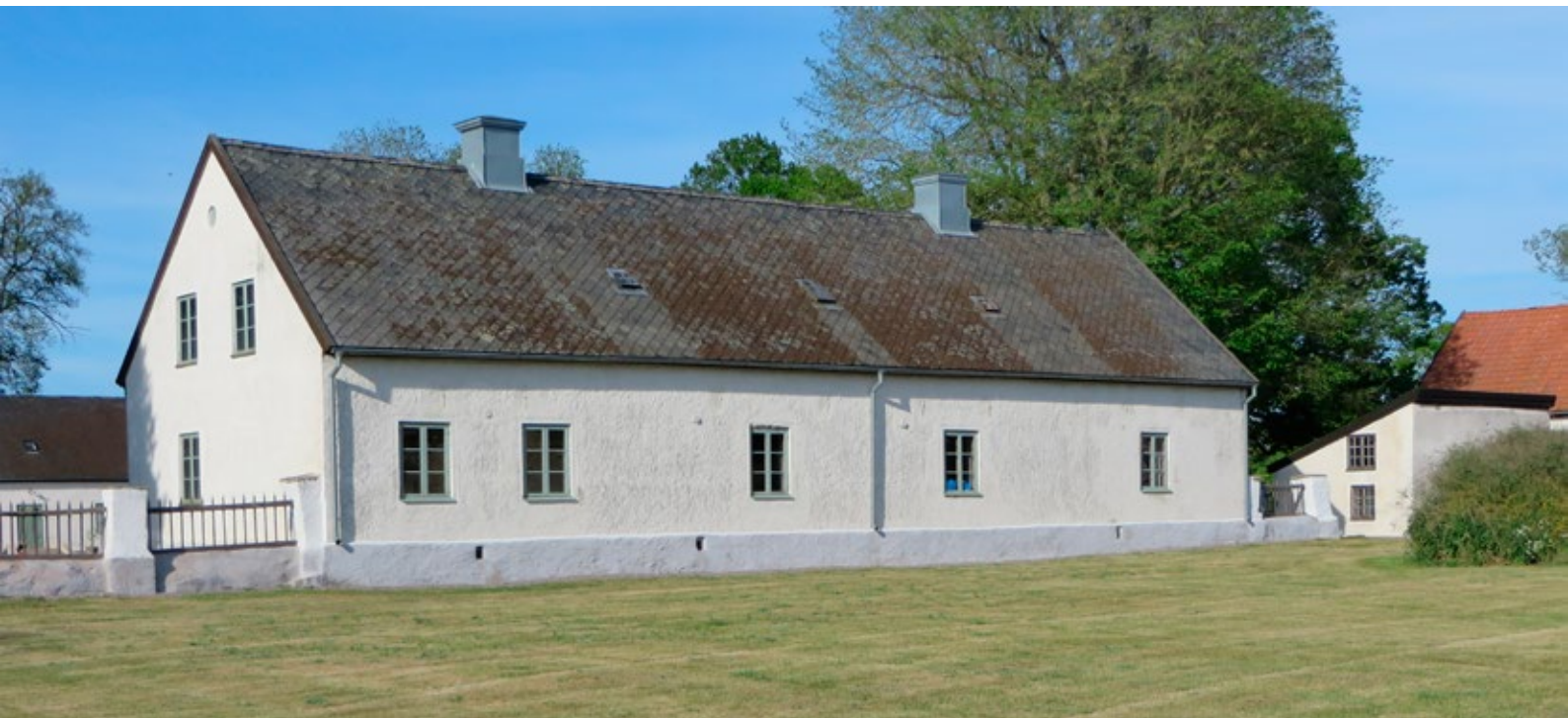
Flygelns fasad mot söder. Fasadens ursprungliga symmetriska fönsterindelning framgår av Henric Georg Melins ritning från 1786. Den asymmetriska indelningen tillkom 1870.
