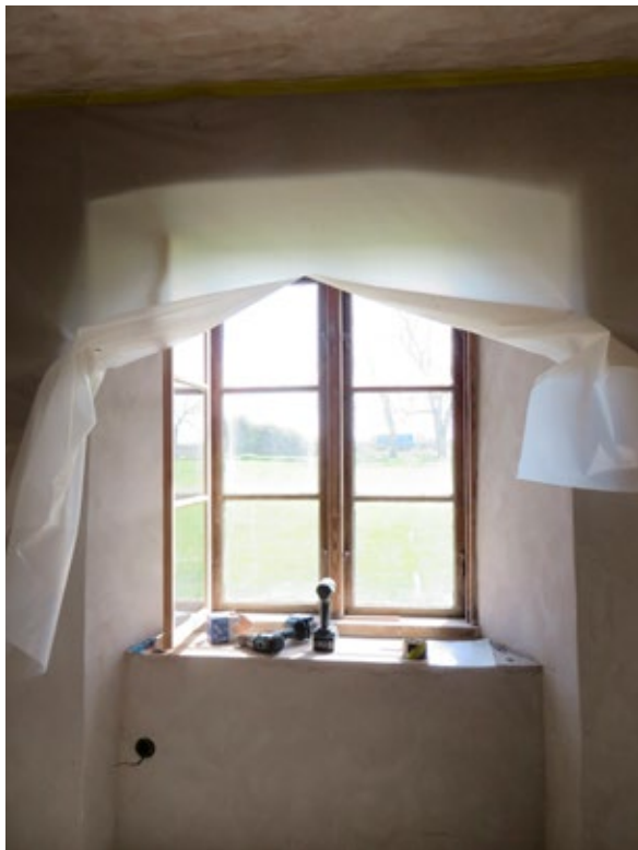
Fönster mot söder under pågående montering av nya innerbågar.
