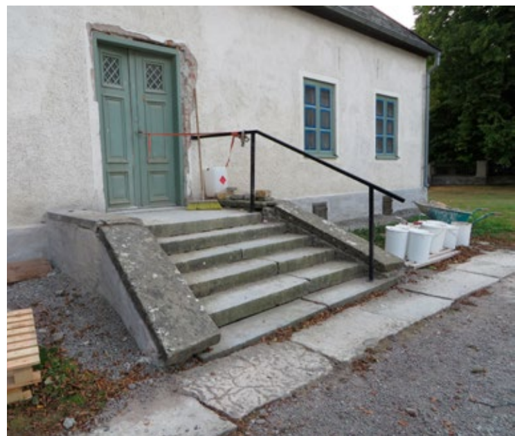
Den västra trappan hade före byggstart försetts med en enkelt utformad handledare av fyrkantstål. Trappan skall under våren 2016 förseas med nya räcken av samma typ som monterats vid den östra entrén.
