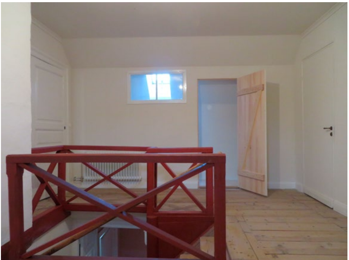
Övervåningens hall (rum 2204) efter åtgärd. Fotografi mot norr. Plankväggen och dörren rakt fram i bild är nya. Genom att inte placera den nya dörren under fönstret kunde fönstrets höjd bevaras.
